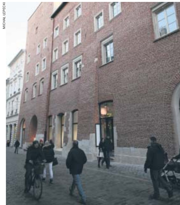
Pięknie prezentują się odnowione elewacje kamienic przy ul. Siennej...
